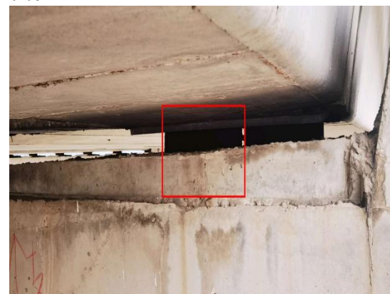
图 3-13：飞鸾互通主线桥右幅 ZZ-R-6-6-2 支座：左侧横向剪切；数量：1 个，角度：20°。
